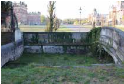
Abb. 3: Ein noch erhaltener Abschnitt beim Nordtor zeigt den ursprünglichen Ausbau des Palaisgrabens mit Sandsteinverkleidung, abschließender Wulstplatte und massiver aufgesetzter Mauer (2019).
