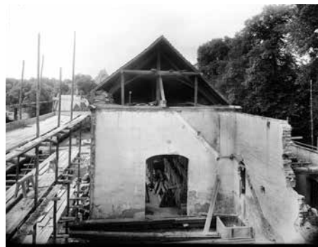
Abb. 16: Umbaumaßnahme 1937. Von der Orangerie ist ein Gießwasserbecken an der Rückwand, die viertelkreisförmige Traufzone und die ausgebaute Treppe auf den Dachboden zu erkennen. Links im Hintergrund steht noch das Potsched.
