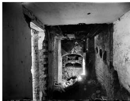
Abb. 17: Orangerie, Sanierungsmaßnahme 1937: Die anschließend abgebrochenen Heizungs- und Backofenreste im nördlichen Gang.
