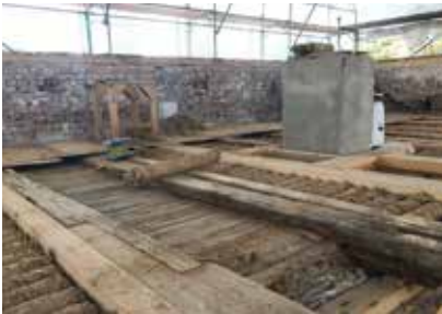
Abb. 5 und 6: Lehmwickeldecken.
